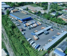
Il deposito ATR di via Pandolfia a Forlì
